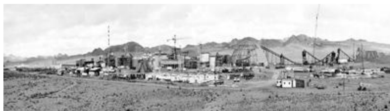
Панорамный вид нового, строящегося цинкового горнозаводского комплекса Скорпион в Намибии. 2002 г.
